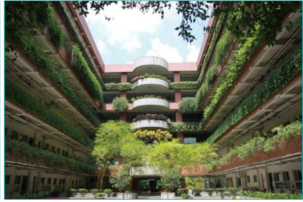
圖說：亞洲大學管理大樓是一棟會呼吸的大樓。
